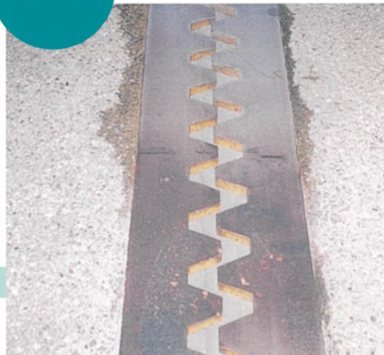
⑪施工完了
