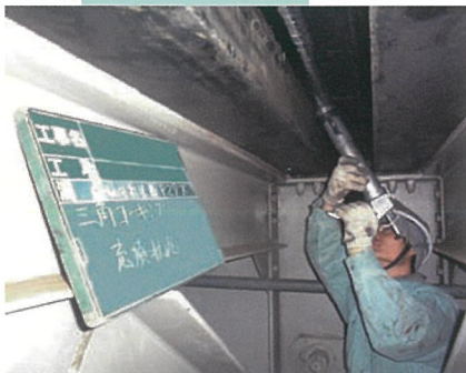
⑦下面・地覆端部コーキング処理
