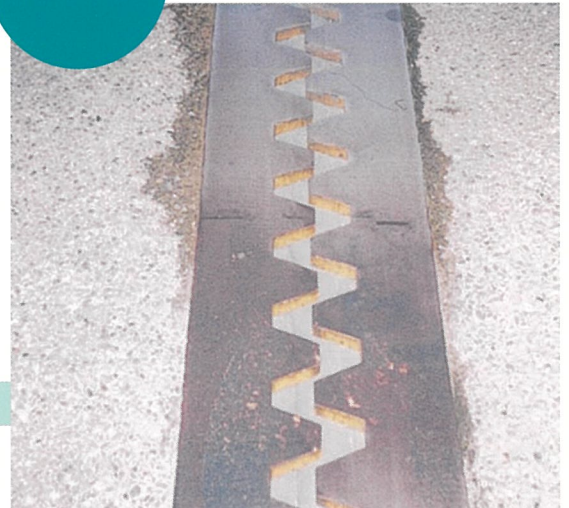
⑪施工完了
